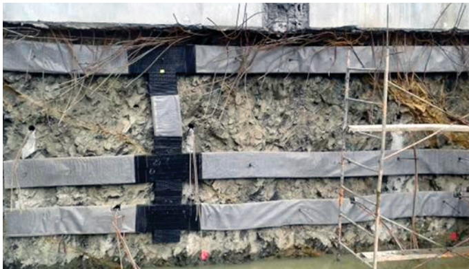
Muros de contención
